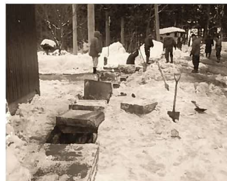
流雪溝の水あがり
