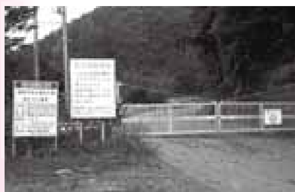
全面通行止の国道344号線
