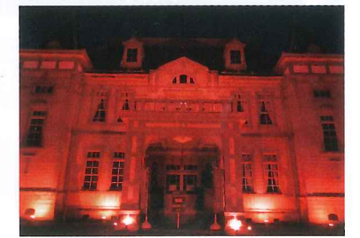
旧米沢高等工業学校本館(米沢市)
