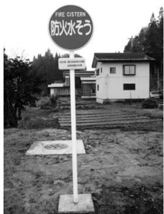
釜淵地区に整備した防火水槽
