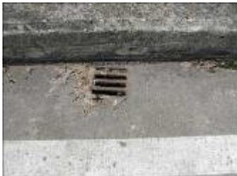
路面から水分が浸透することにより、コンクリート部材のひび割れや遊離石灰の発生を促進し、鋼部材の腐食を生じさせます
