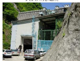
大沢川発電所
