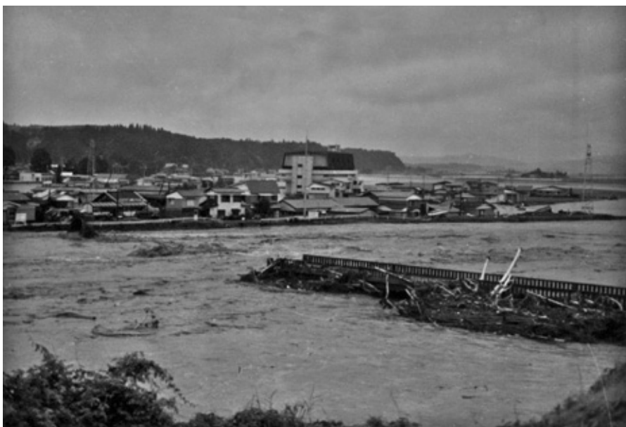
水害を防止するための施策が求められる
