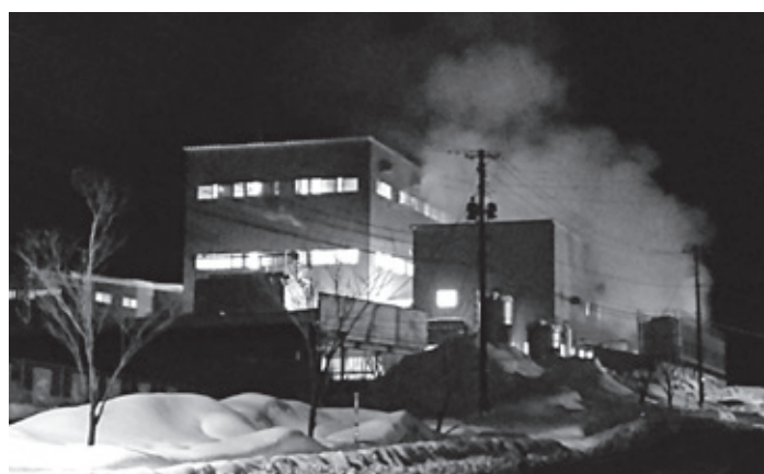
木質バイオマス発電施設(新庄市)
