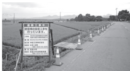
防雪柵の工事現場
