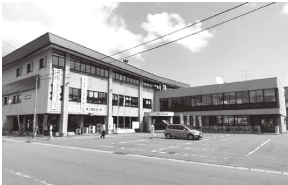
築52年経過した役場庁舎
