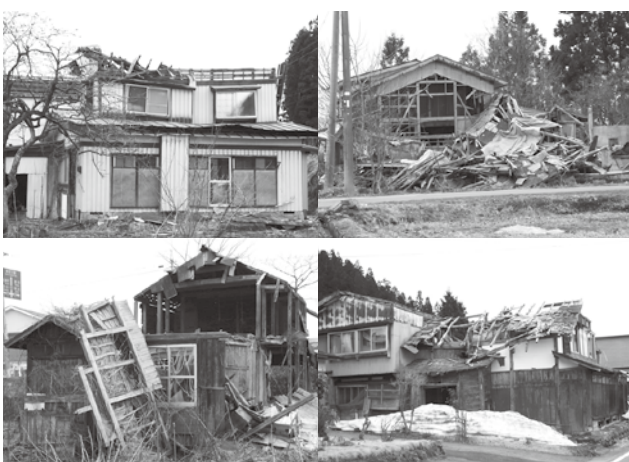
崩壊が進む空家の現状
