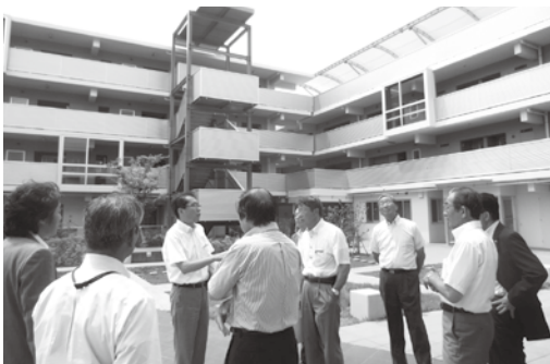
高台に建設された災害支援住宅
