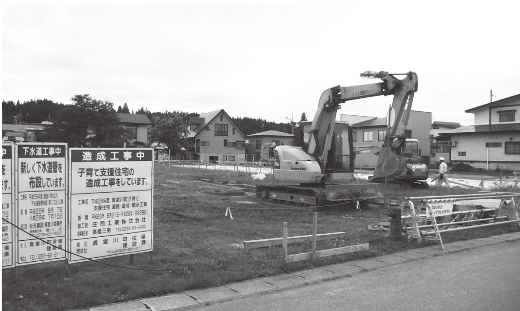
完成にむけ急ピッチで進む工事の様子
