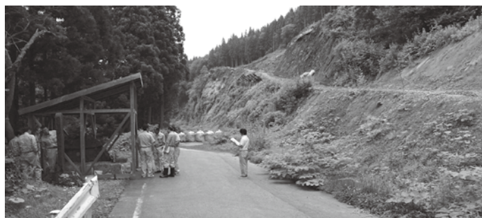
工事が再開される象獅子
