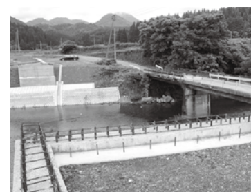
完成を待つ田代橋
