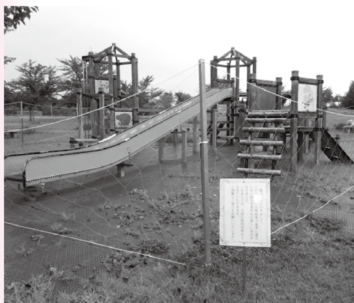
使用禁止になっている遊具
