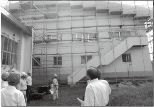
真室川中学校の屋根改修工事
