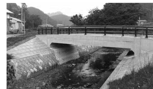
自然に配慮した下三滝橋
