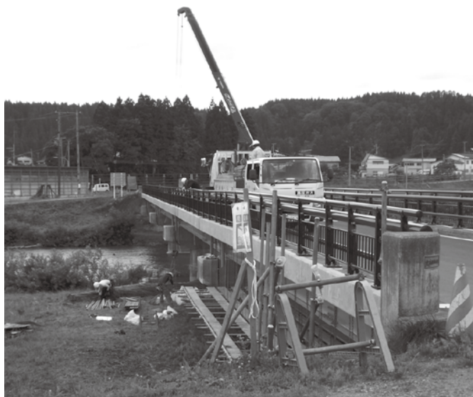
矢の沢橋の補修工事の様子
