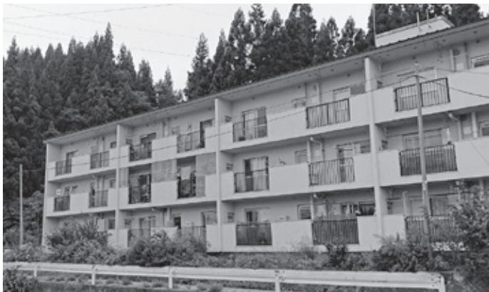
改修された梅の里団地
