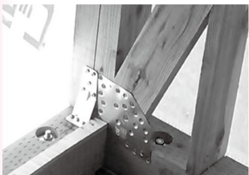
プレートを使った耐震補強
