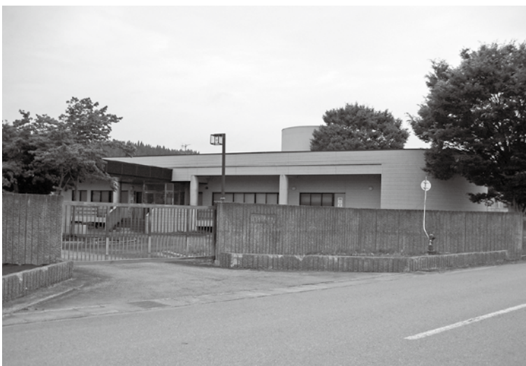
443世帯の生活排水を処理している浄化センター
