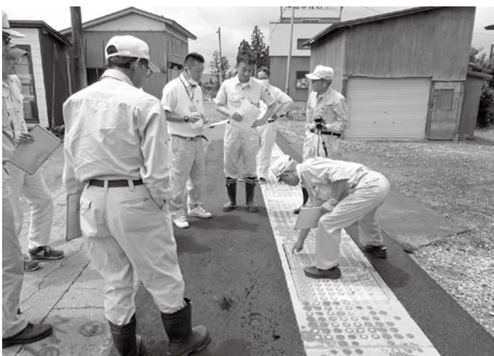
流雪溝整備状況調査(投雪口の状況を皆で確認)
