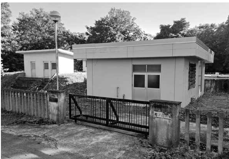
令和9年度までに施設統廃合のため廃止撤去予定の秋山浄水場
