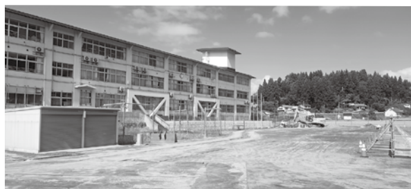
あさひ小工事状況
