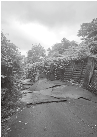
町道小国西川線の現状
