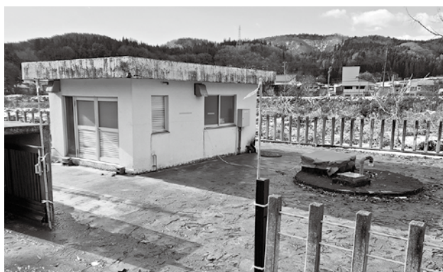
安楽城第1水源池施設
