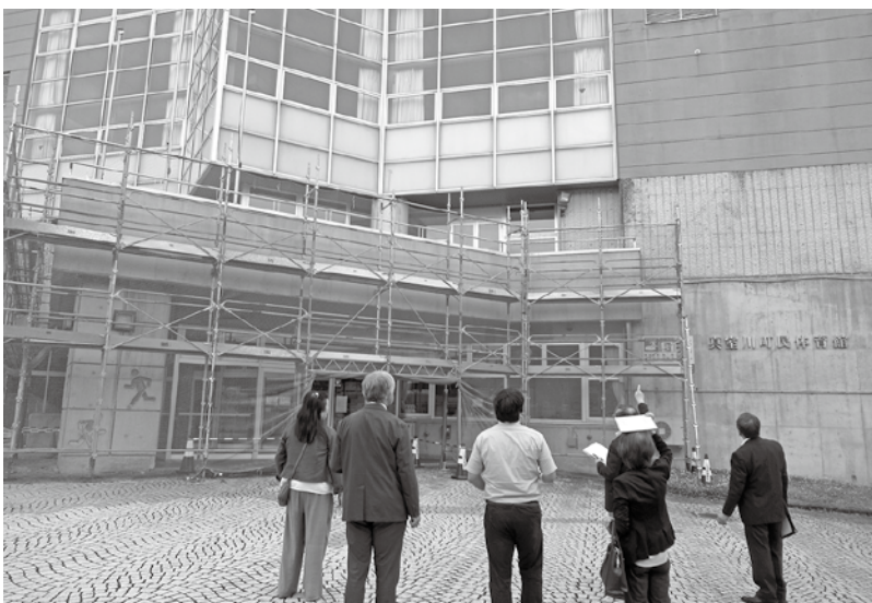
町民体育館の壁面改修工事
