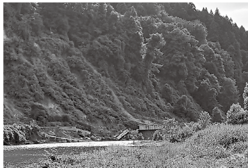
令和6年7月豪雨神ヶ沢川の被災現場
