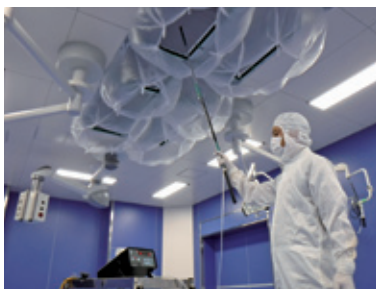
空調設備の測定作業
