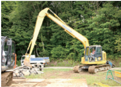
重機機械操作
