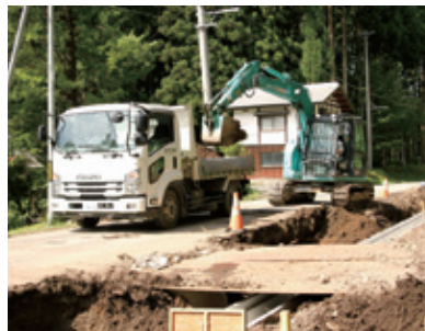
土砂の運搬作業
