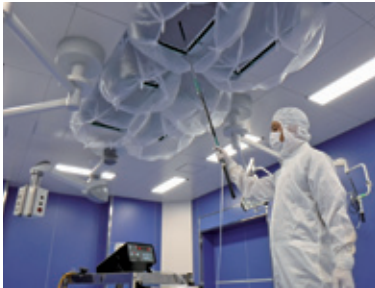
空調設備の測定作業
